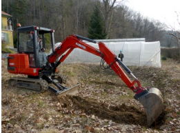
Abb. 1: Ausheben des Teichs mit Kleinbagger
