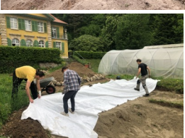
Abb. 4: Auftragen des Schutzvlies (zweilagig)
