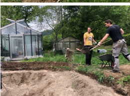
Abb. 3: Schutzschicht aus Feinsand
