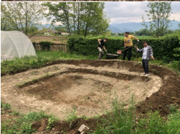
Abb. 2: Tiefenstufenmodellierung per Hand
