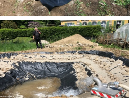
Abb. 6: Vorsichtiges Befüllen des fertigen Teichbetts
